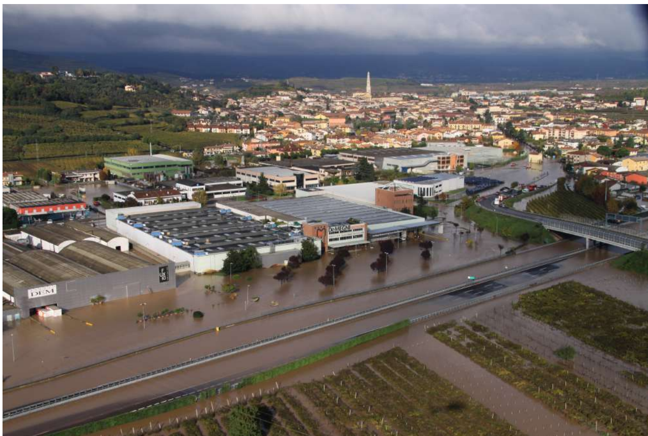
Figura 27 - Esiti della rotta del torrente Alpone a Monteforte (VR) (2010)
