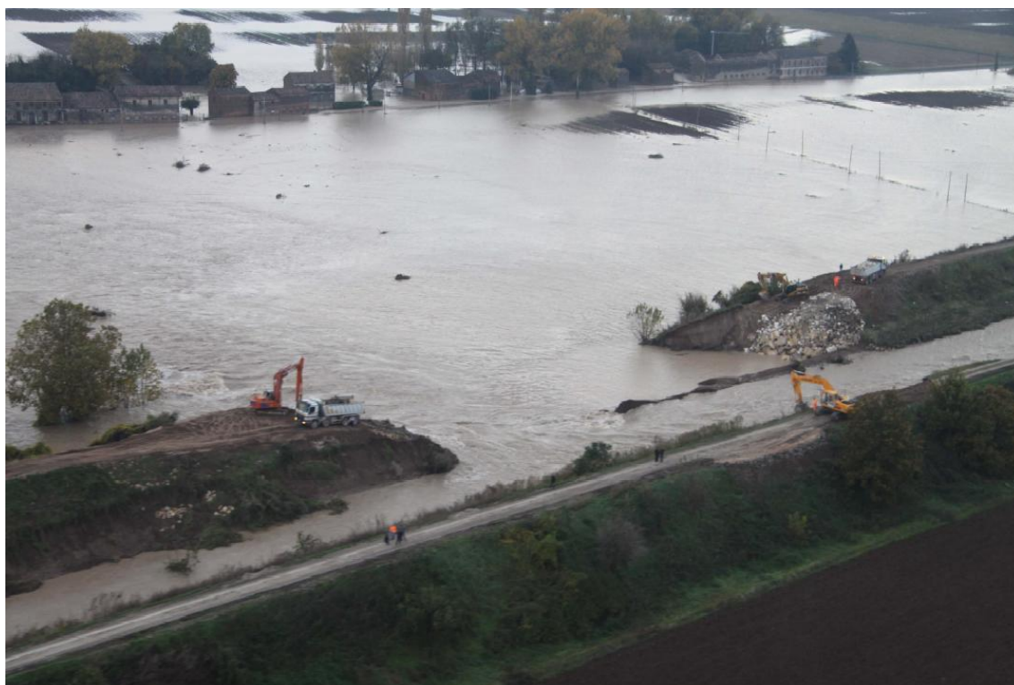
Figura 7 - La rotta del Frassine in comune di Saletto - 2010
