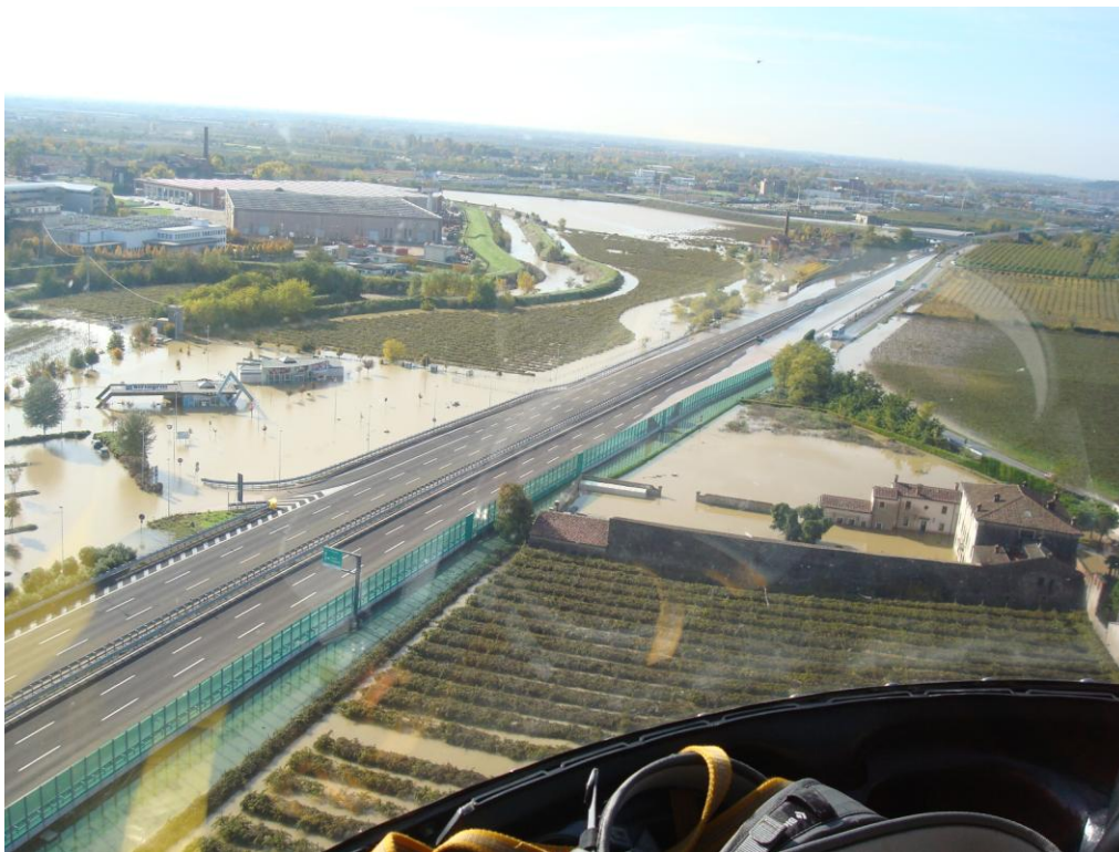
Figura 32 – Esiti della rotta del torrente Alpone a Monteforte (VR) (2010)
