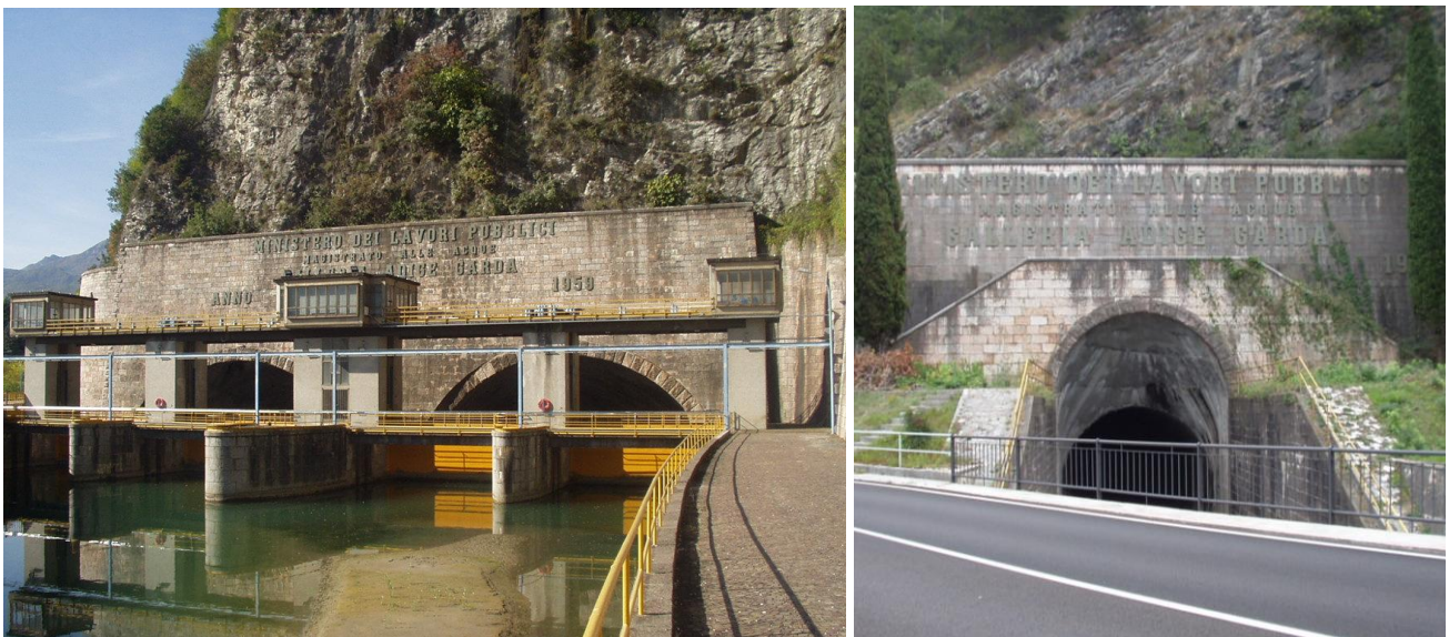
Figura 30 – L'imbocco (a sx) e lo sbocco (a dx) della Galleria Adige - Garda
